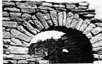
図-2 石積みアーチ構造の例
